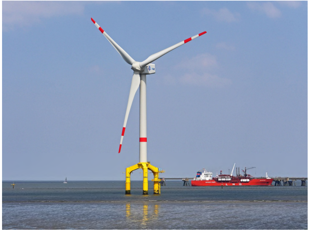
Offshore-Windkraft ist ein wichtiges Modul bei der Energiewende.
